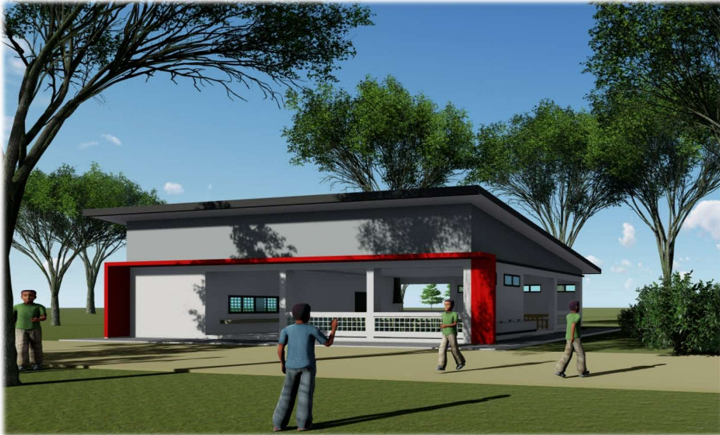
โรงอาหารขนาดเล็ก 156 ที่นั่ง โรงอาหารขนาดเล็ก 156 ที่นั่ง ในเขตแผ่นดินไหว กรอบอาคาร 16.00 x 19.00 เมตร สูง 5.15 ม. พื้นที่ 304 ตรม.
