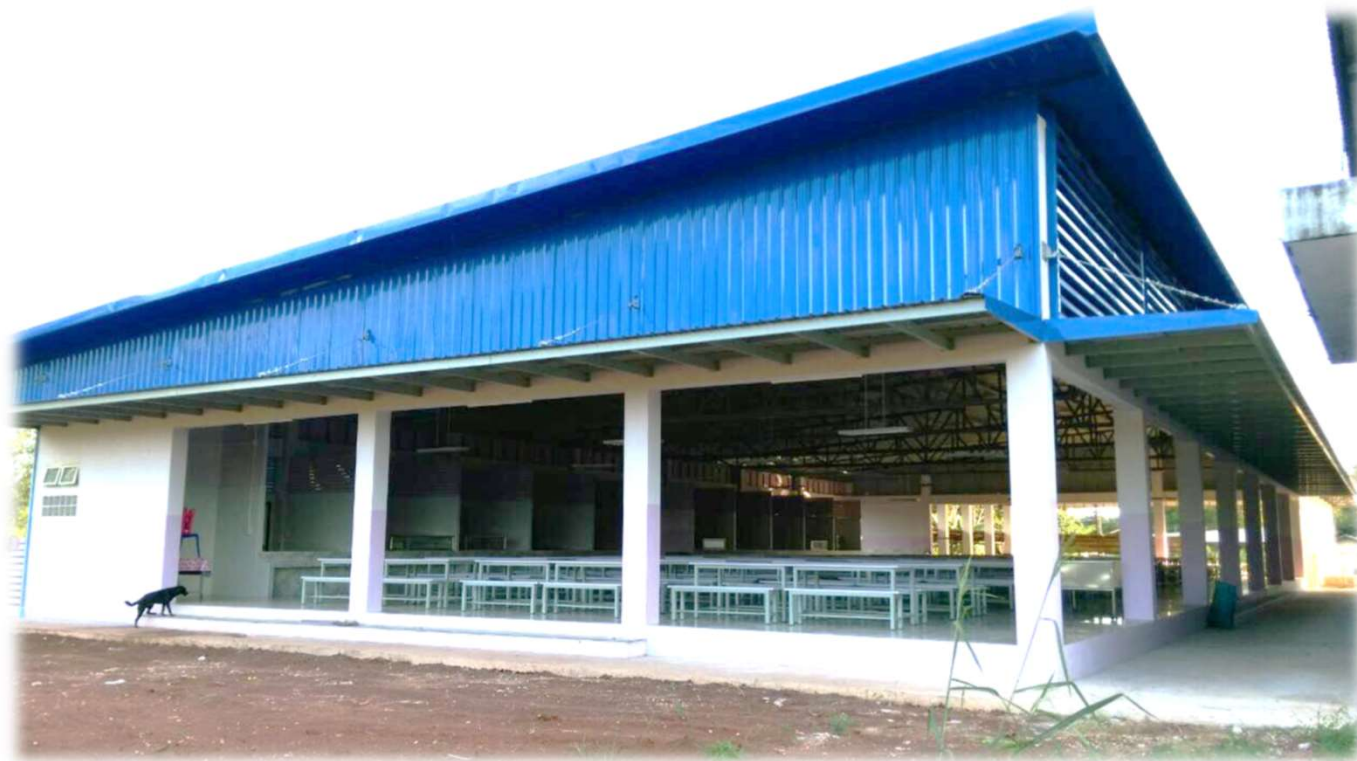
โรงอาหารขนาดเล็ก 260 ที่นั่ง โรงอาหารขนาดเล็ก 260 ที่นั่ง ในเขตแผ่นดินไหว กรอบอาคาร 19.00 x 24.00 เมตร สูง 6.30 พื้นที่ 352 ตรม.
